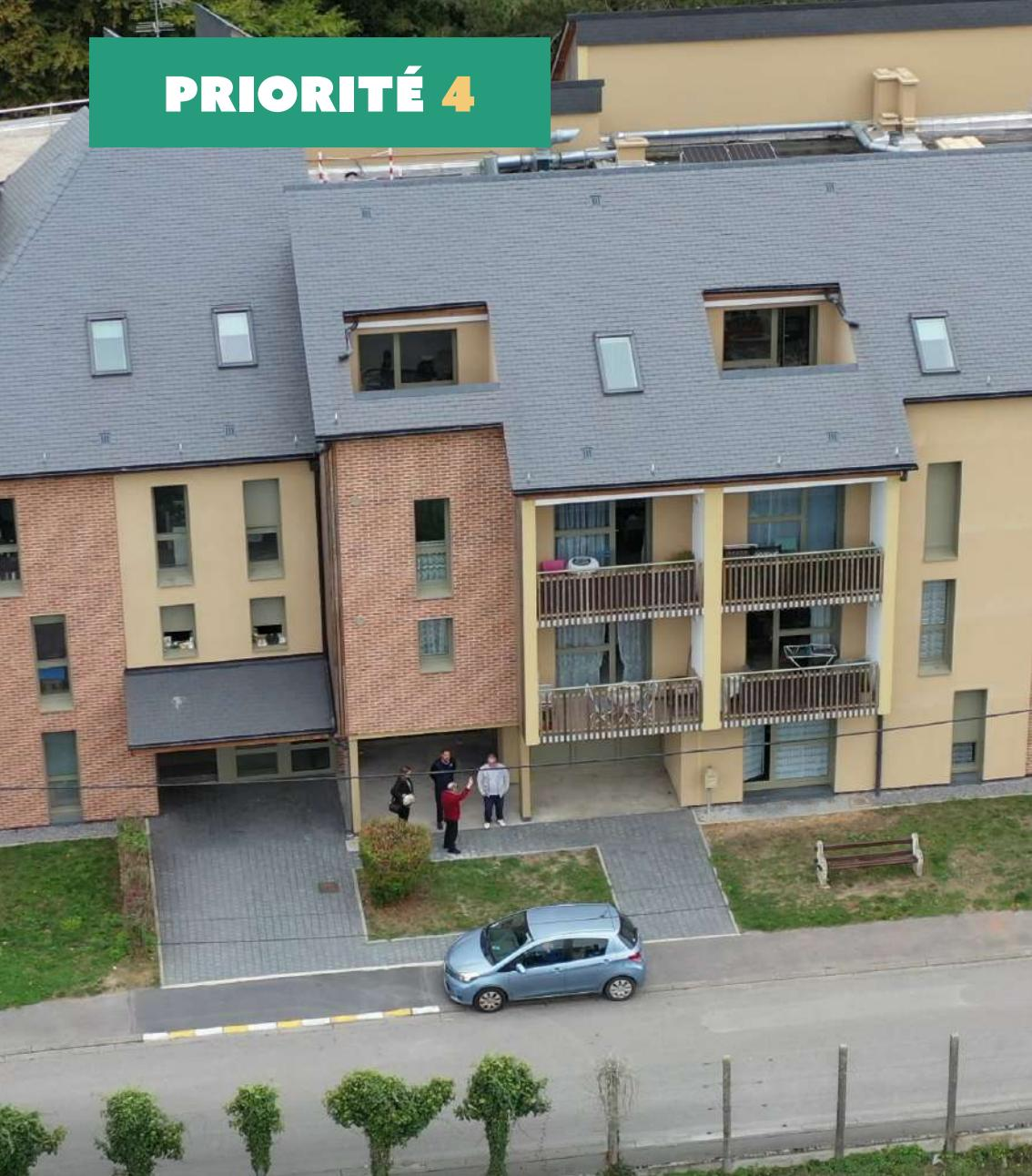
Résidence située à Guise (02), réhabilitée et rénovée par le Groupe Clesence dans le but de réduire la facture énergétique des locataires et d'améliorer leur confort de vie au quotidien : installation de volets roulants électriques, isolation thermiques, panneaux solaires et fenêtres double vitrage.
